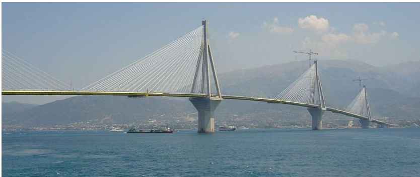
Pont de Rion-Antirion en Grèce, mis en service en 2004, d'une longueur totale de 2880 m, avec des portées de 286 m et 560 m (1999-2004)
