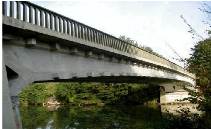
Pont de Luzancy sur la Marne, commencé en 1941 et inauguré en 1946. Pont à béquilles d'une portée de 55 m. C'est l'un des premiers grands ouvrages de Eugène Freyssinet en béton précontraint.
