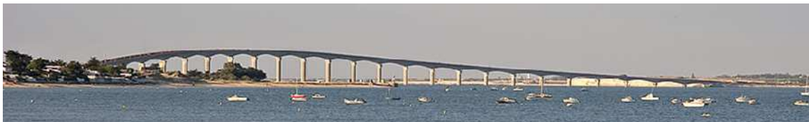
Pont de l'Île de Ré, inauguré en 1988. La longueur totale de l'ouvrage est de 2927 m, avec des portées de 110 m.
