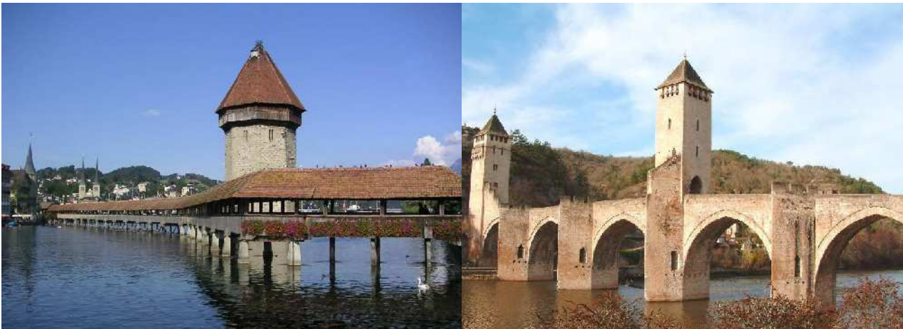
Le pont de la Chapelle à Lucerne (Suisse), construit en 1365.
